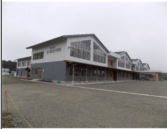
東北小学校校舎改築工事(H31年完成)
