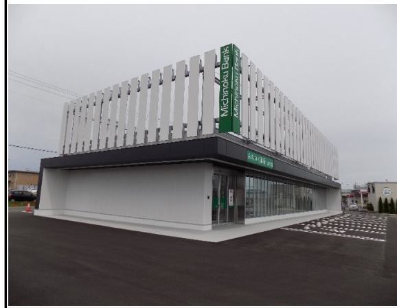
みちのく銀行七戸支店新築工事(H31年完成)
