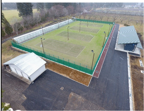
七戸運動公園テニスコート改修工事(H30年完成)
