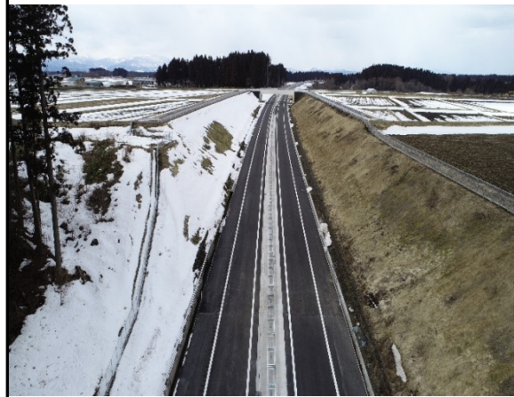
後平北地区道路改良工事(H31年完成)
