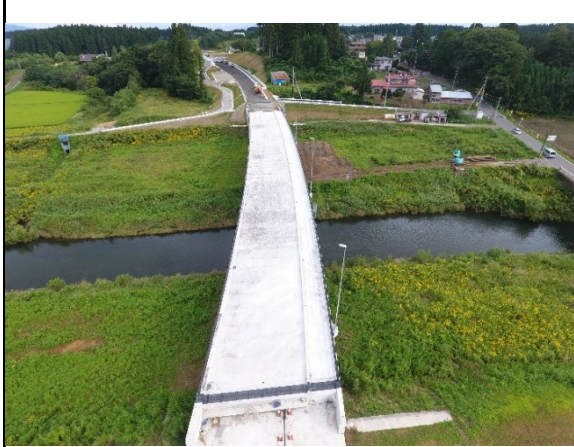
国道394号橋梁整備(天堂橋)工事(H30年完成)
